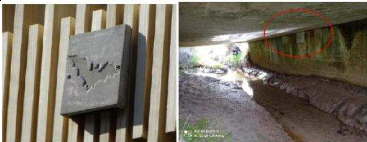
A GAUCHE : EXEMPLE DE GÎTES ARTIFICIELS POUR ESPÈCES ANTHROPOPHILES / À DROITE : GÎTE POSÉ SUR OUVRAGE
