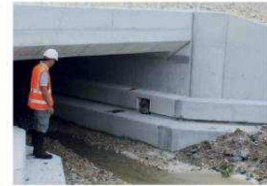
⑪ Exemple d'abris créés dans la banquette faune d'un ouvrage. Source : Michel Bramard OFB.
