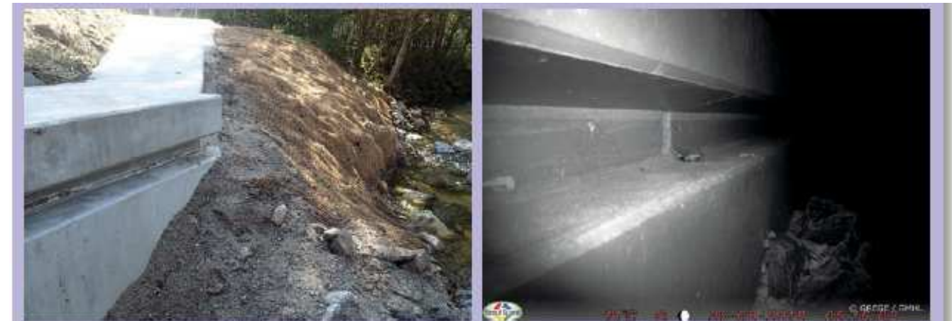
⑫ Aménagement au sein de la banquette faune d'un cheminement pour les micromammifères. Source : P. Fournier GREGE.
