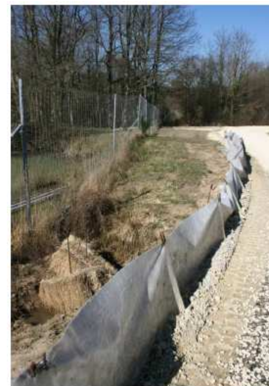
FIGURE 50 : EXEMPLE DE PROTECTION CONTRE LA DIFFUSION DES BOUES ET POUSSIÈRES DE CHANTIER EN BORDURE DE PISTE
