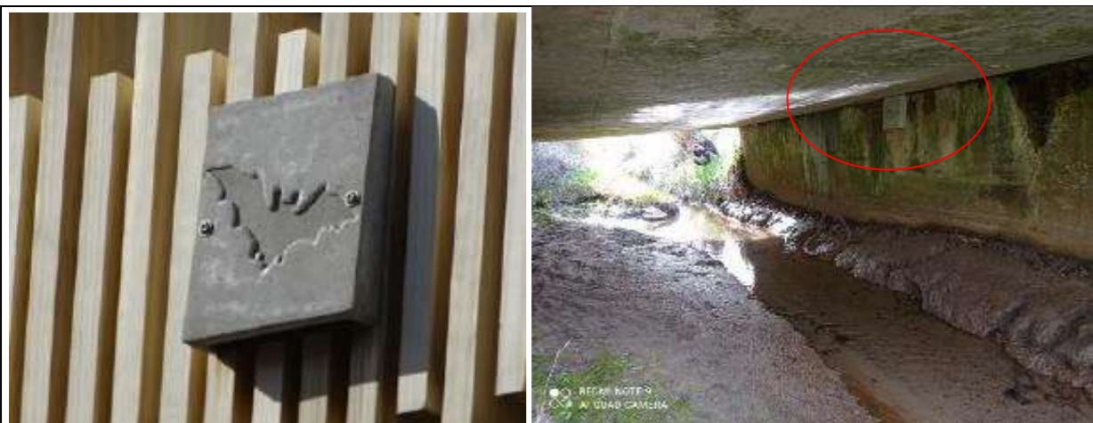
A GAUCHE : EXEMPLE DE GITES ARTIFICIELS POUR ESPECES ANTHROPOPHILES / A DROITE : GITE POSE SUR OUVRAGE
