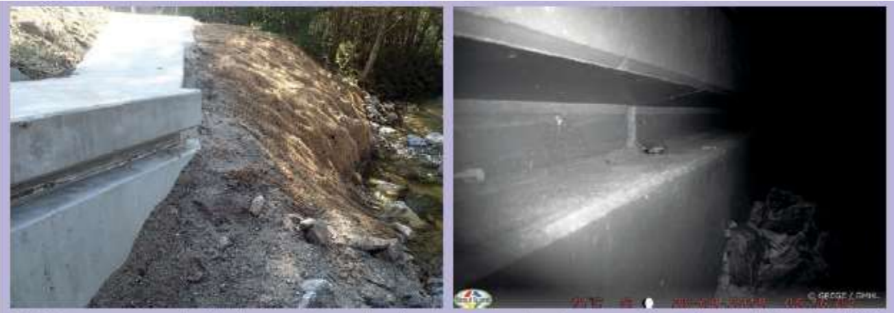
15 Aménagement au sein de la banquette faune d'un cheminement pour les micromammifères. Source : P. Fournier GREGE.
