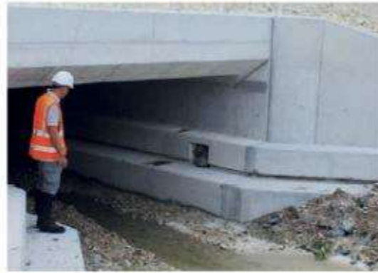
14 Exemple d'abris créés dans la banquette faune d'un ouvrage. Source : Michel Bramard OFB.
